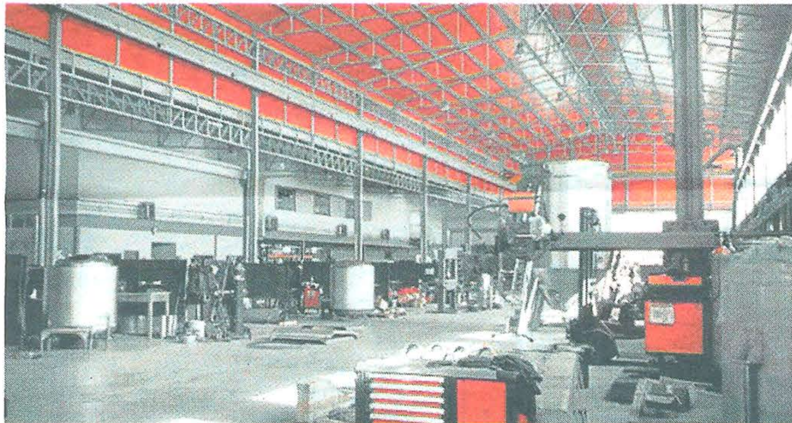
Instalaciones de Tramega en Terrassa (Vallès Occidental).
