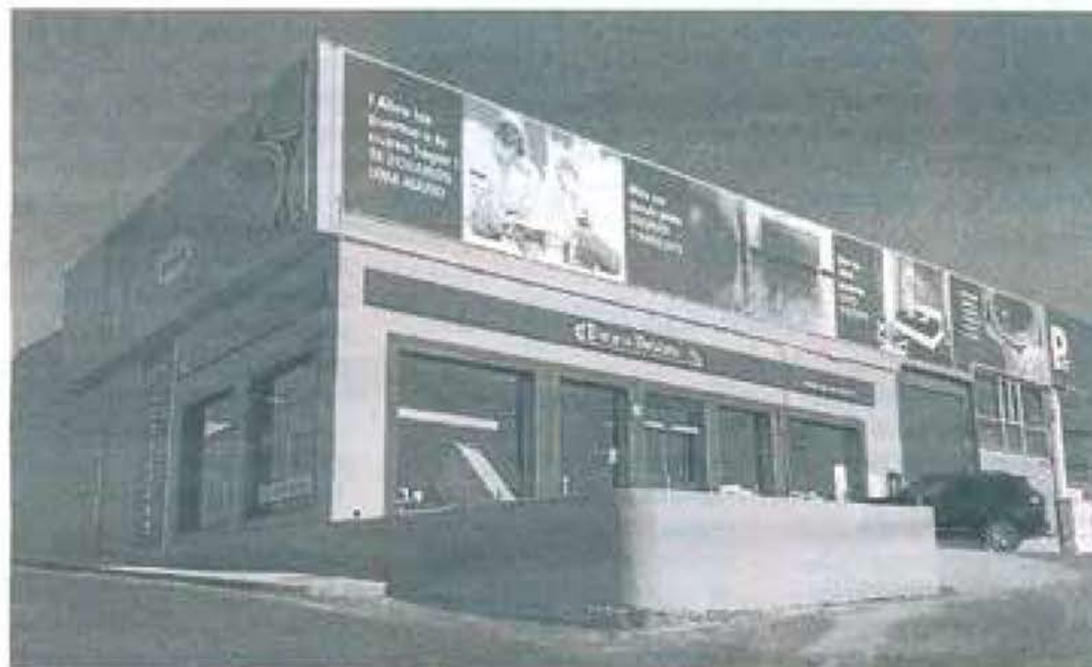
Fachada de una de las últimas tiendas abiertas por Pinturas Andalucía, en Almería.
